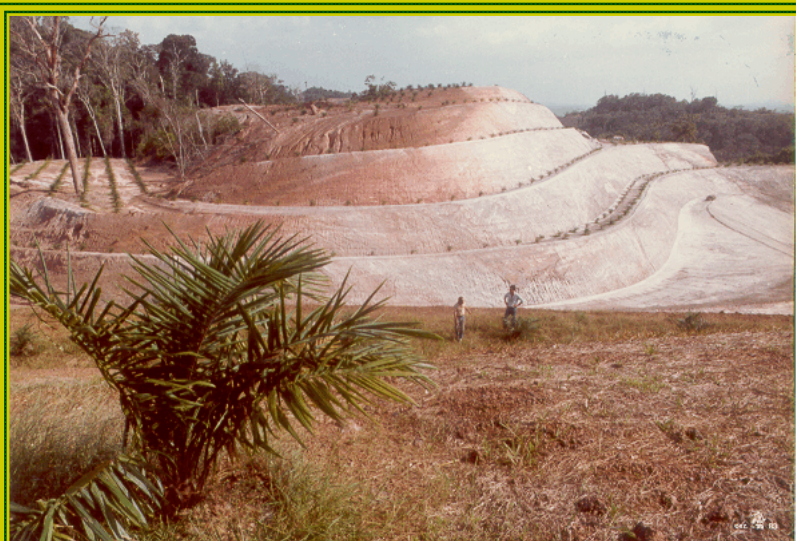
Vista de uma das minas de Serra do Navio (A-12), na qual está sendo executado trabalho de regeneração dos taludes, através da plantação de gramíneas, dendê, etc.
